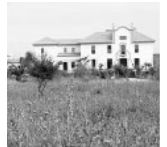
Vista panorámica de «La Antigua Estación»
